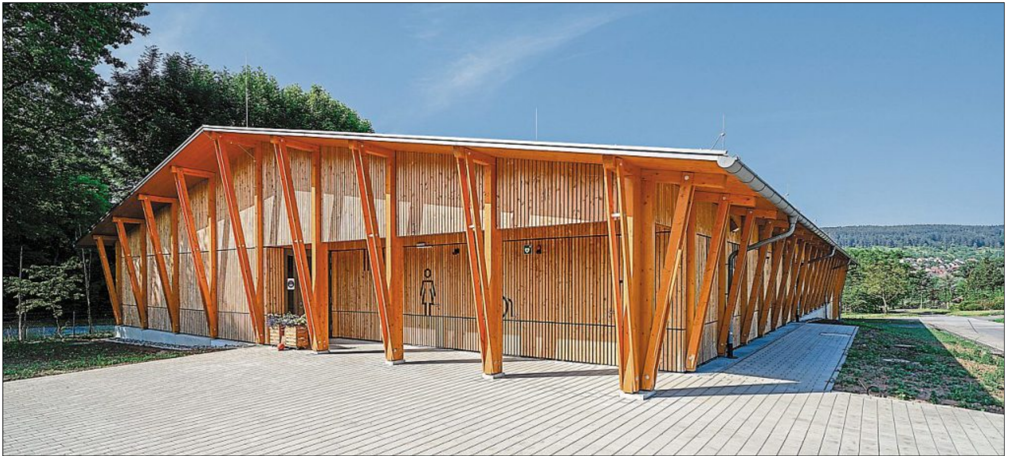
Das Mehrzweckgebäude mit filigranen Brettschichtholzstützen.
