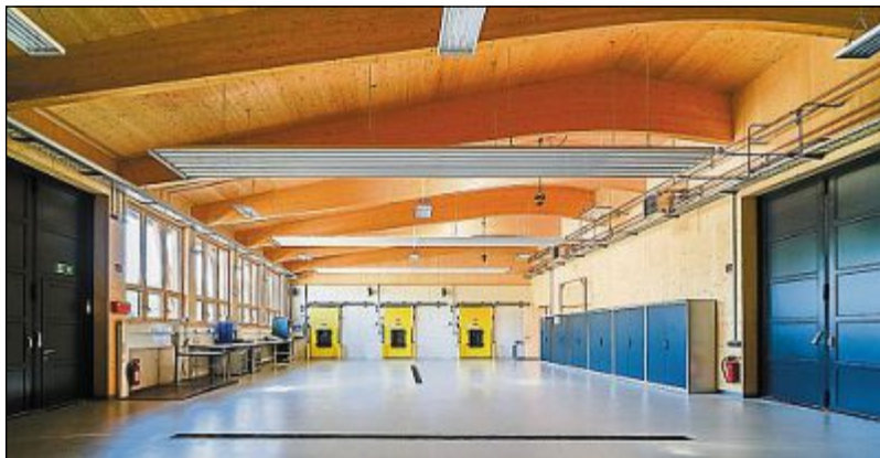
Produktaufbereitung im Mehrzweckgebäude, im Hintergrund das CA-Lager.
